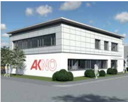
Im Sommer 2012 wurde mit dem Bau der neuen Bezirksstelle in Horn begonnen. Geplante Fertigstellung: Juni 2013
